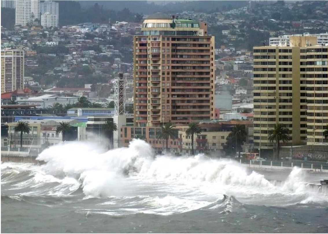
Figura 7: Sobrepaso generado por la marejada del 8 de agosto de 2015 en el sector costanera, a un costado del puerto de Valparaíso (The Clinic).
