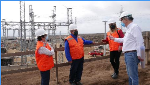
Visita SSR El Granizo.
